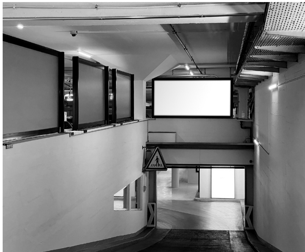
RAMPE DESCENTE ÉTAGE -1 À ÉTAGE -2
