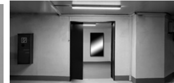
ÉTAGE -2 SORTIE TUNNEL
